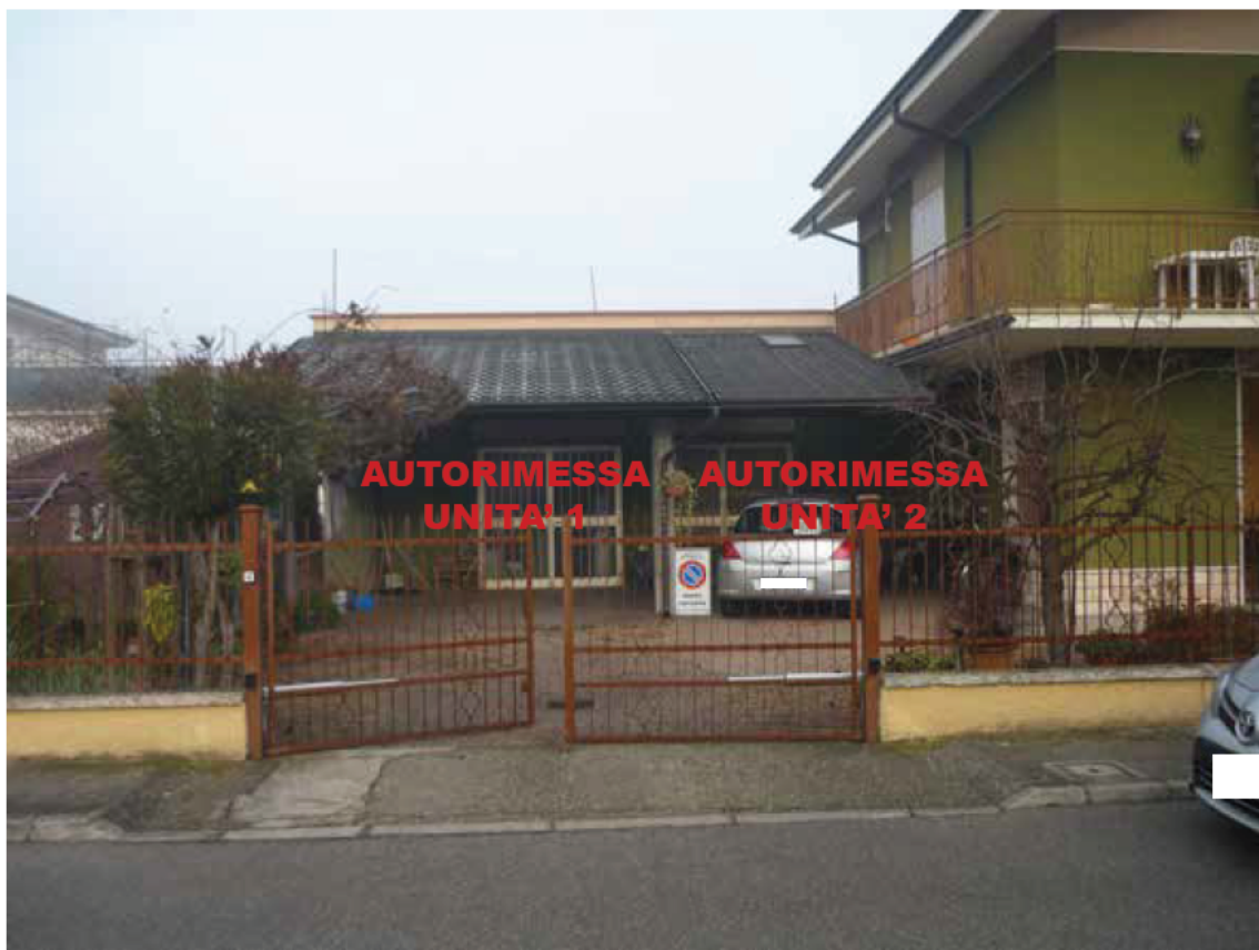
foto 07 - vista esterna autorimesse
