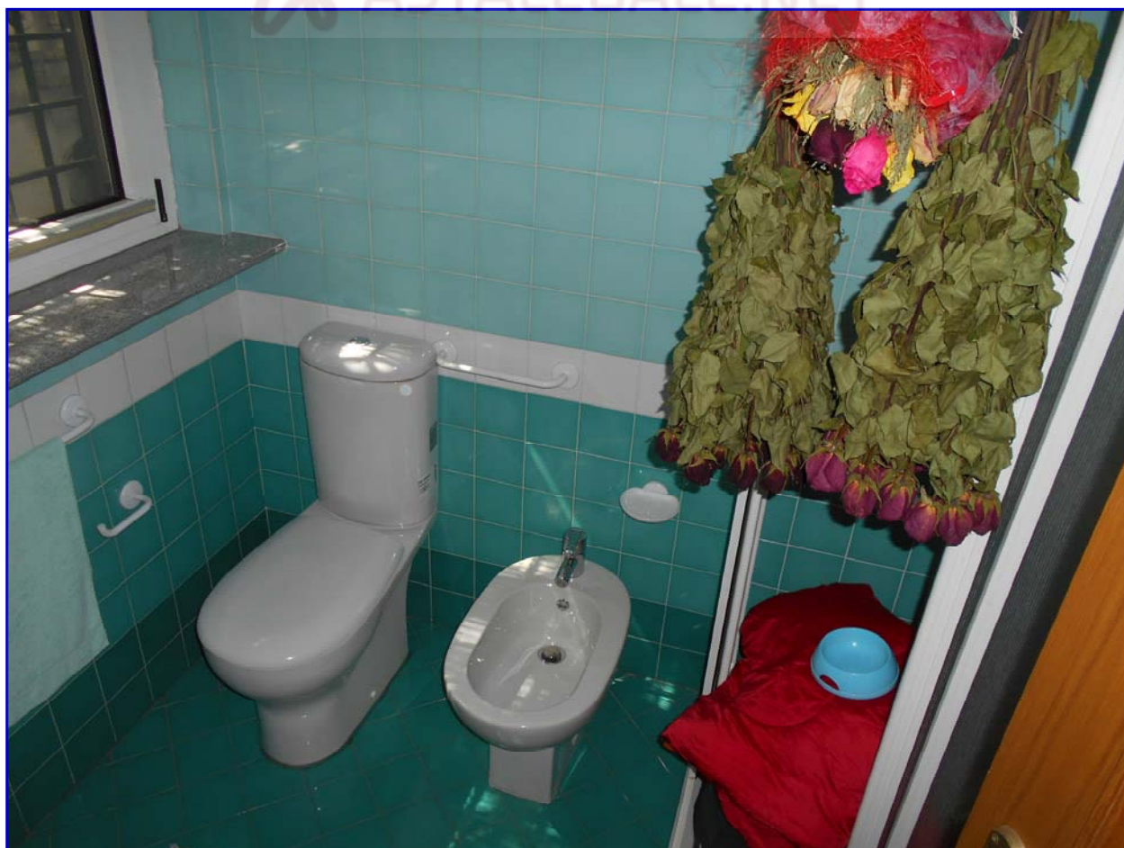
Foto 31: Piano interrato, bagno a servizio esclusivo della camera degli ospiti.
