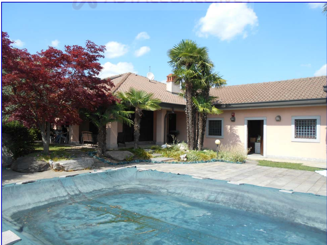
Foto 5: Vista esterna dell'immobile (lato Ovest) scattata da giardino pertinenziale. Particolare della piscina esterna.
