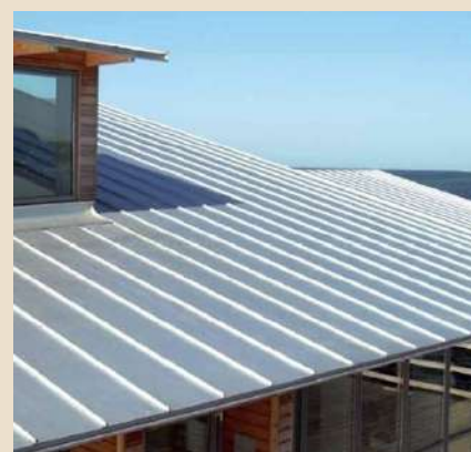
Manto di copertura, su falde inclinate di lamiera
