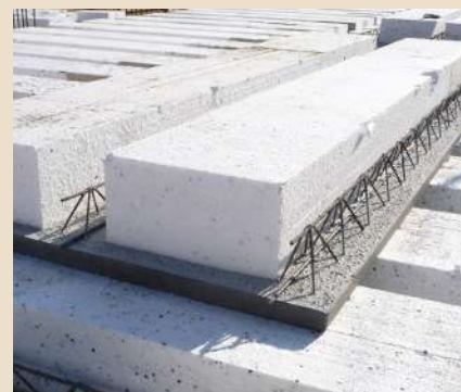
Solai interpiano in predalles gettato in opera
