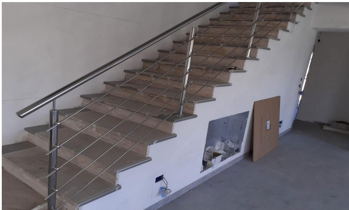
Scala già posata in altro cantiere
