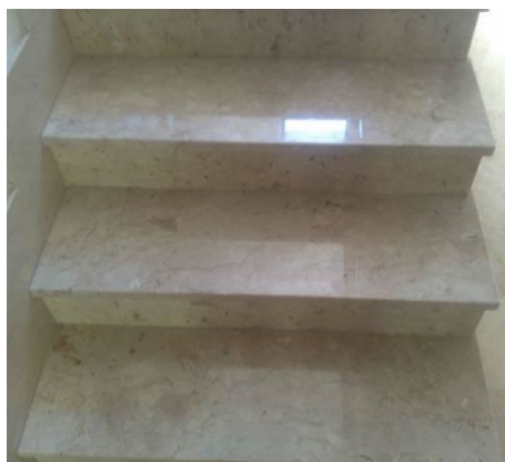
Scala interna dal piano primo all'interrato
